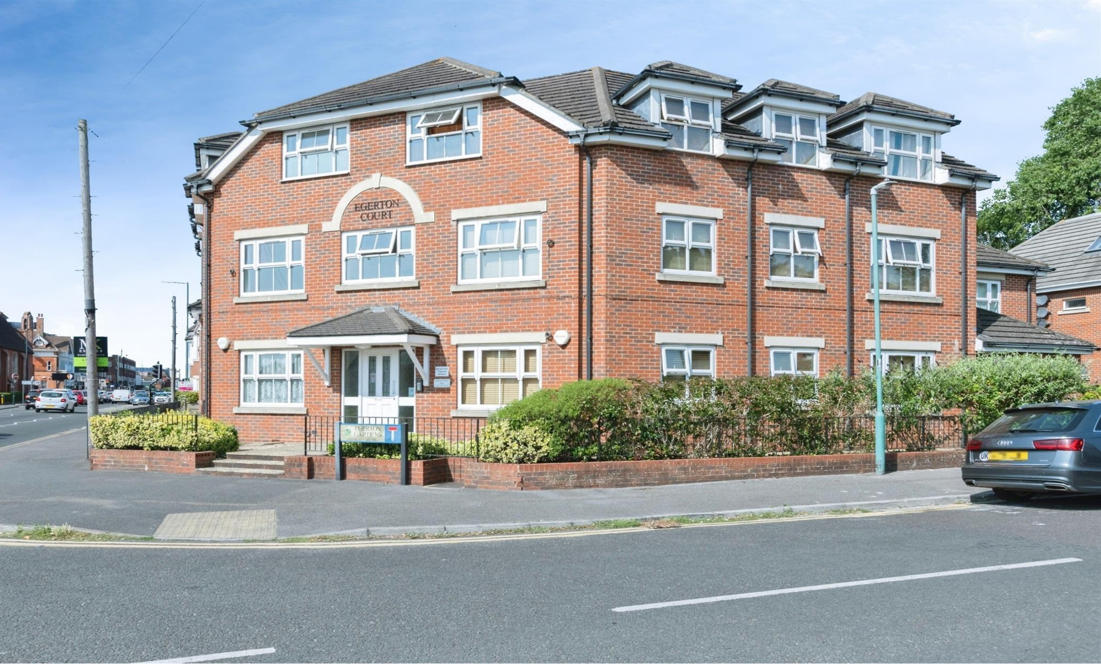
Egerton Court Egerton Gardens, Bournemouth BH8 9AB
